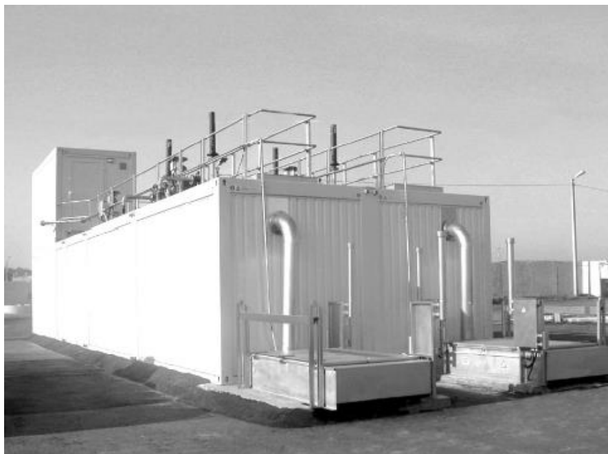
Рисунок 5 – Комплексные локальные сооружения очистки «Адмирал».
